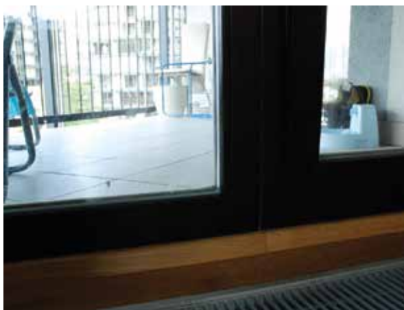
Obr. 2b - Provedená lokální oprava lazury
