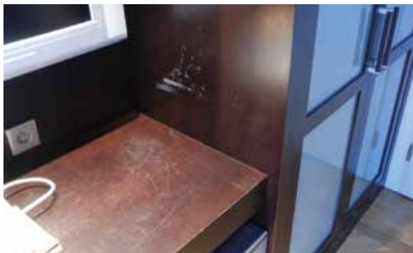
Obr. 3a - Poškrábaný lak na dřevěném nábytku
