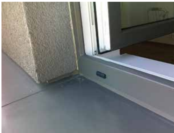
Obr. 1b - Provedená oprava sanační fólií
