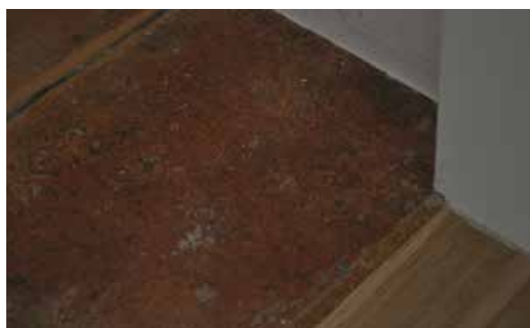
Obr. 4b - Provedená oprava keramickým tmelem
